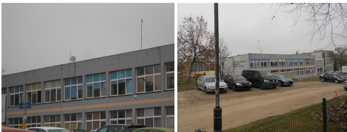
Widok obiektu wraz z zainstalowanym zespołem antenowym
